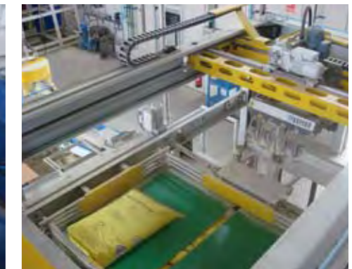
Vannes de préparation des couches
